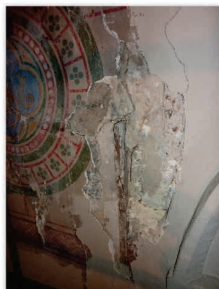
Détails médaillons après dégagement, consolidation et solins périphériques
