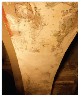
Détail arc triomphal après dégagement et rebouchages
