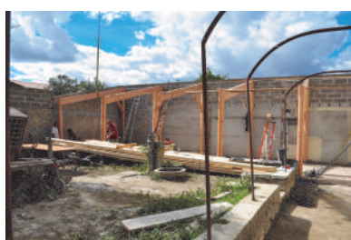
Terrassement et coulage de la chape réalisés par les employés communaux
